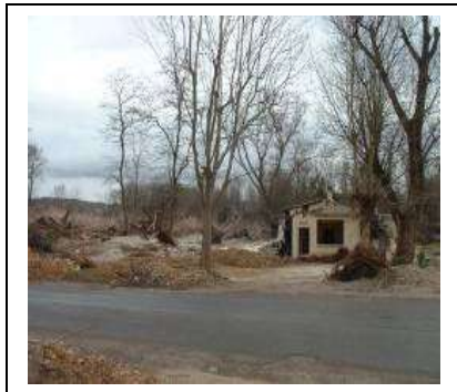
Guinguette dévastée en rive droite le long de la RD 106 au nord de Cassagnoles (photo BCEOM)
