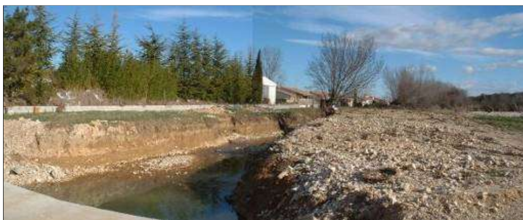
Lit mineur du Valat recalibré par la crue dans la traversée de Saint-Mamert-du-Gard (photo BCEOM)
