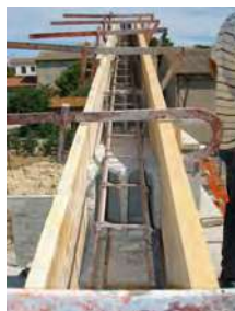
Mise en place d'un chaînage au niveau du rampant d'un bâtiment
