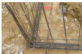
Nœud de chaînage - Continuité mécanique
